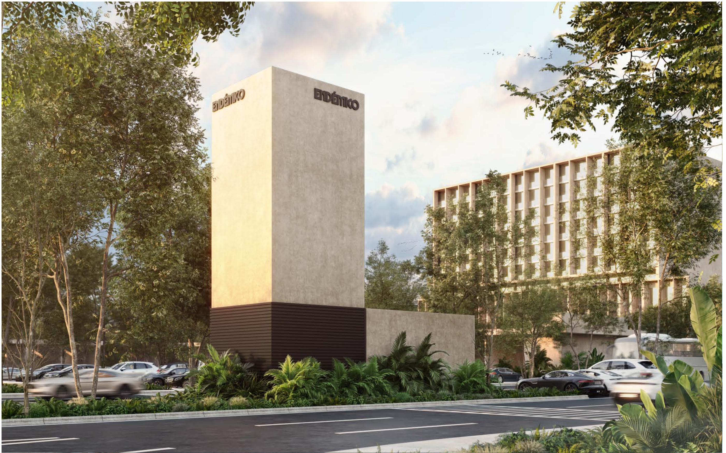
CASETA DE ACCESO
